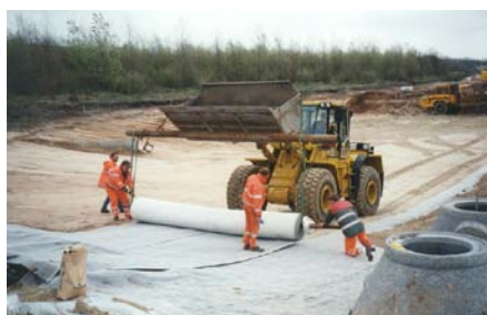
Udlægning af membran
